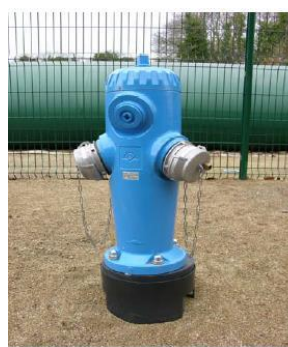
Poteau d'aspiration de 150 mm muni de 2 sorties de 100 mm et d'un carré de manœuvre
