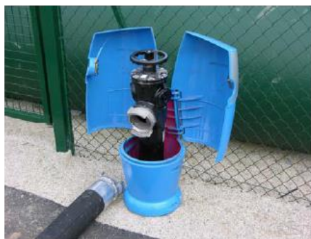
Poteau d'aspiration classique de 100 mm muni d'une seule sortie de 100 mm et d'un volant de manœuvre
