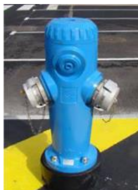
P.A.R.S. de 150 mm muni de deux sorties de 100 mm sans volant ni carré de manœuvre.
