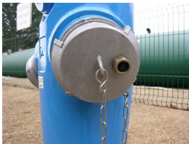
PA de 150 mm muni d'un Airclap
