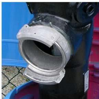
PA de 100 mm muni d'une sortie de 100 mm, avec raccord fixe à tenons verticaux
